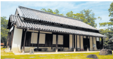
旧田中家 鍵屋資料館 主屋、枚方市、クリエイティブ・コモンズ・ライセンス 表示-改変禁止 2.1
